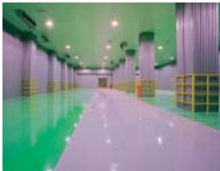
高機能塗り床材 (アイカピュール) 倉庫床面への使用例
